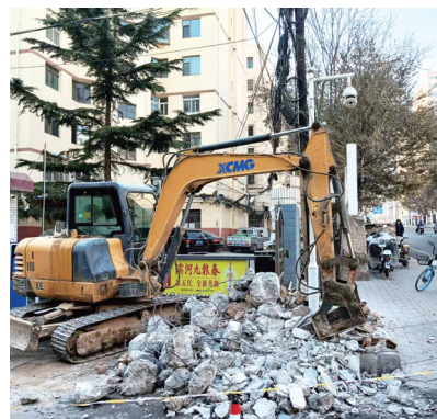
遮挡视线墙体拆除。
