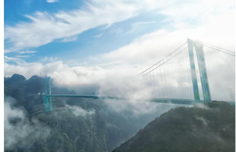
28日，贵州花江峡谷大桥正式通车。大桥桥面距水面625米，高度超过北盘江第一桥近60米，成为新的世界第一高桥；大桥主桥跨径1420米，居山区桥梁跨径世界第一，可谓“横竖”都是世界第一！花江大峡谷被称为“地球裂缝”，花江峡谷大桥是贵州六枝至安龙高速公路的控制性工程。一桥飞架，天堑变坦途。大桥全长2890米，可将两岸通行时间从两个多小时缩短到两分钟左右。
