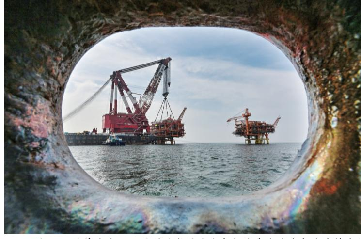
9月8日，随着重达4700吨的油气平台上部组块在渤海南部海域精准就位，垦利6-1油田10-1北区块Ⅱ期开发项目建设工作取得重要进展，渤海亿吨级油田又一油气平台完成海上安装。垦利6-1油田位于渤海南部海域，石油探明地质储量超1亿吨，是我国在渤海莱州低凸起浅层勘探领域发现的首个亿吨级岩性大型油田。
