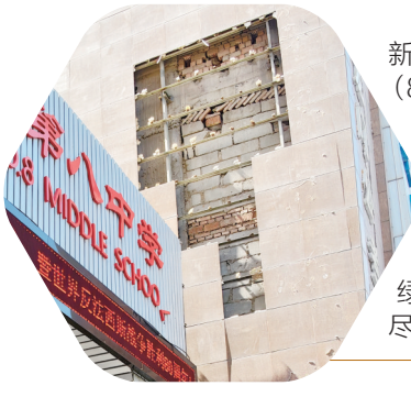
外墙瓷砖大面积脱落。
