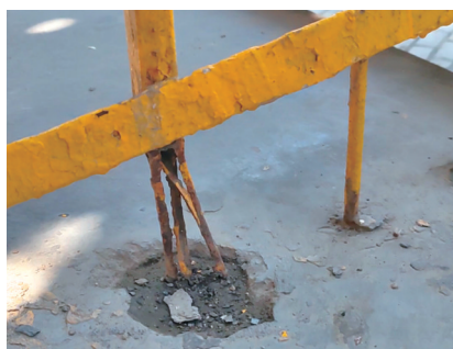
旋转楼梯栏杆多处出现断裂。
