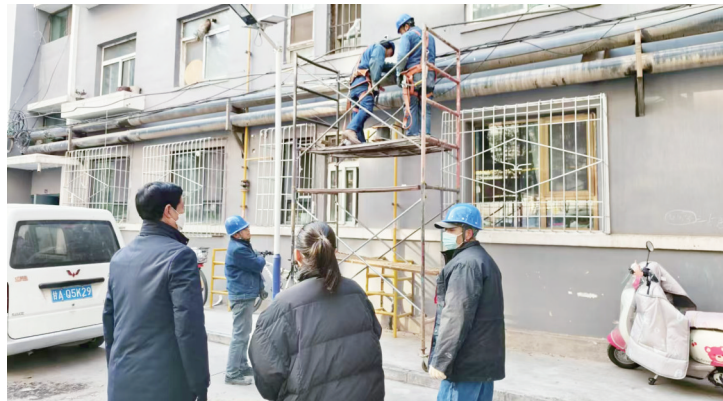
改造供电线路现场。
