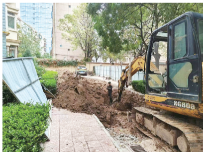
更换破损管道。
