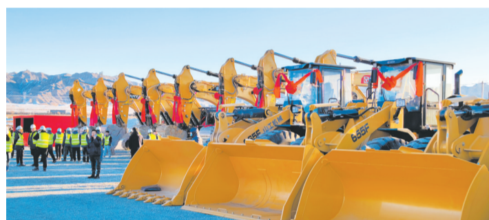
开工建设现场。
