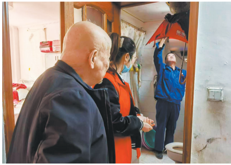
为居民清除管道堵塞物。
