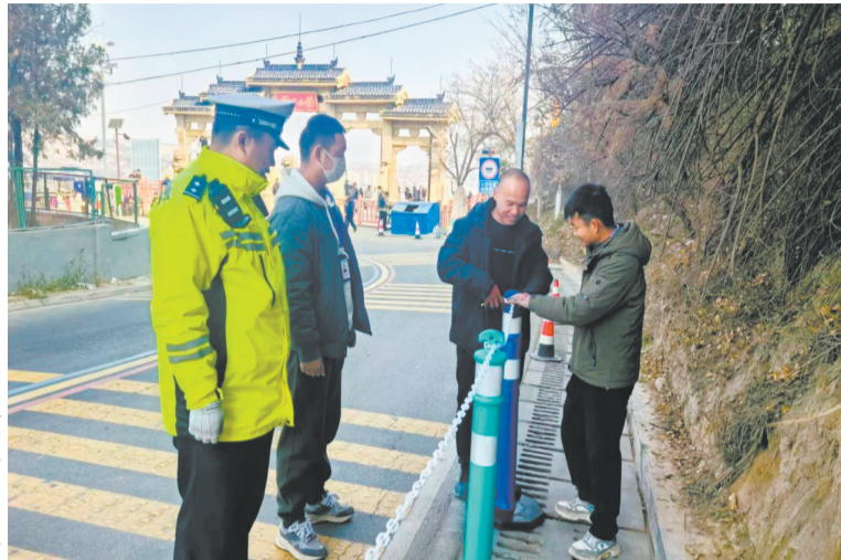
安装安全隔离柱。
