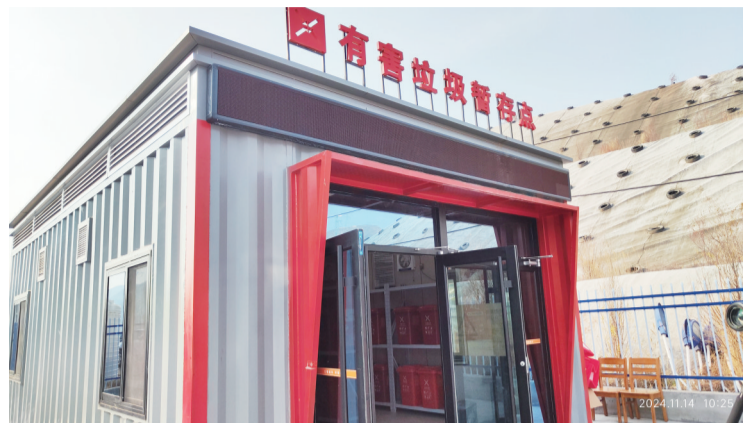
兰州市城关区有害垃圾暂存点。
