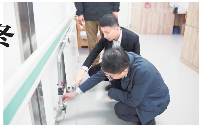
检查供暖设备。
