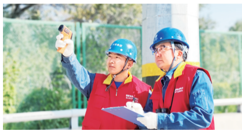
工作人员对换电站供电设备进行巡视测温。
