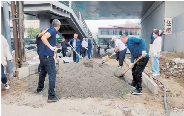
进行修补作业。
