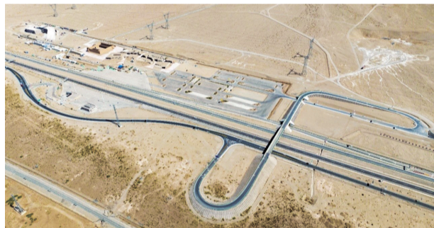
柳格高速悬泉置出入口。
