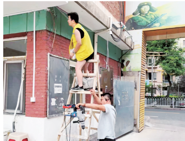
更换老化电线。
