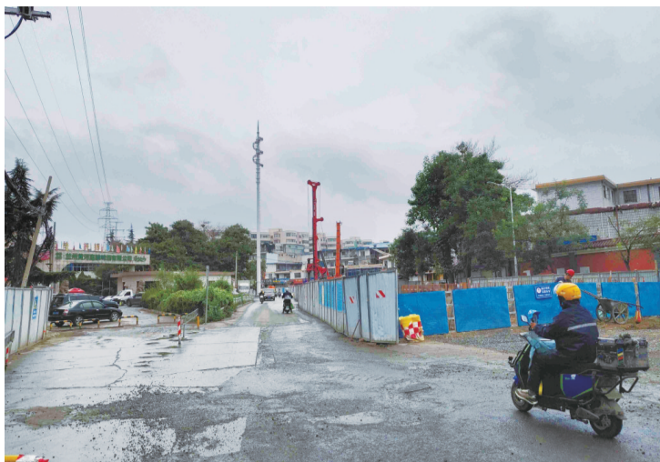
施工中的七里河区火星街综合管廊。
