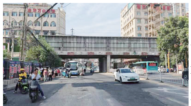
硷沟沿路路面已修好。
