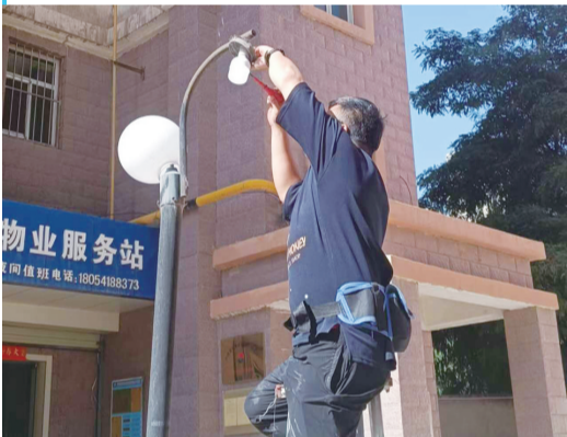
物业人员维修路灯。
