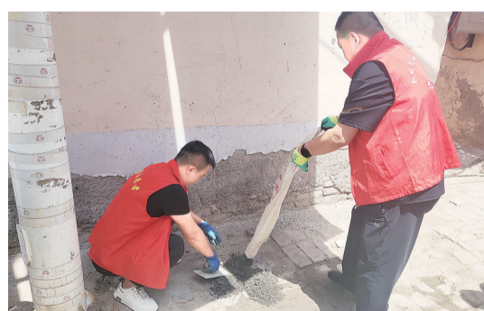
修复小巷路面。
