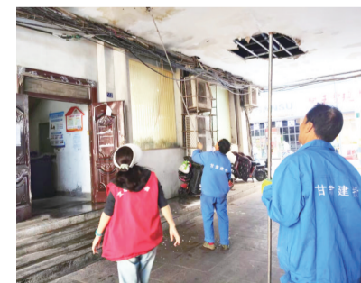
解决漏水隐患。
