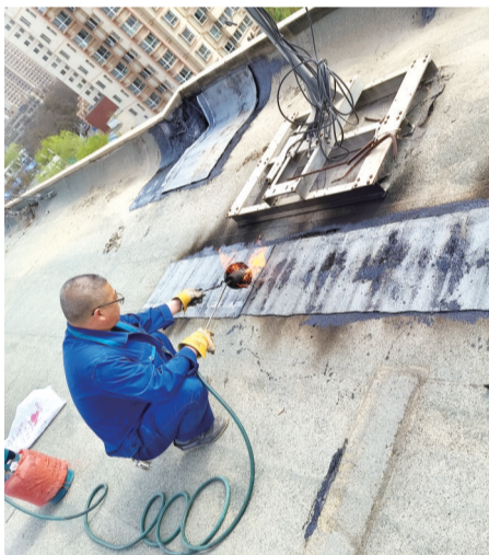
加固维修防水层。
