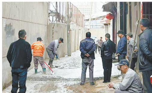
管道更新施工。
