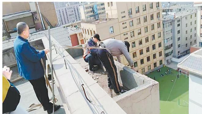
近日，兰州市城关区张掖路街道金塔巷社区网格员在日常巡查中，发现金塔巷91号居民楼临街外墙的墙皮“鼓包”脱落，存在安全隐患。
