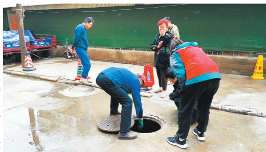
维修漏水管道。
