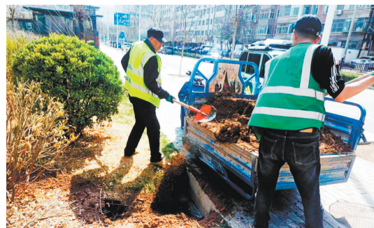
修理漏水管道。
