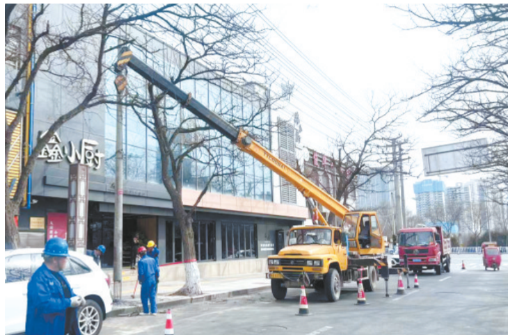
废弃线杆拆除现场。
