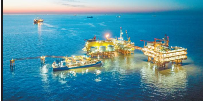
1月25日,位于渤海湾西南部的埕北油田油气处理与岸电设备共建平台——CEPC(中心平台)正式投产,该平台可使油田接入来自陆地的绿色电力,减少海上“自发电”带来的天然气和原油消耗。这是当日拍摄的埕北油田全景。
