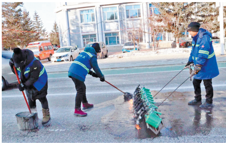
工作人员在对一段结冰路面进行除冰作业。网络图片
