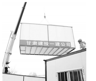
板房临时安置点施工现场。
