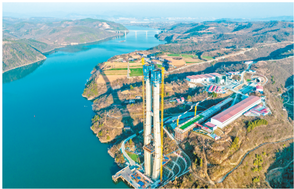
12月24日，由中铁十一局承建的西(安)十(堰)高铁汉江特大桥P4主塔顺利封顶。汉江特大桥位于湖北省十堰市，是一座梁桁组合结构斜拉桥，全长917.45米，P3、P4两座主塔高度均为186.5米，共设置80对斜拉索，主跨420米。新华社照片
