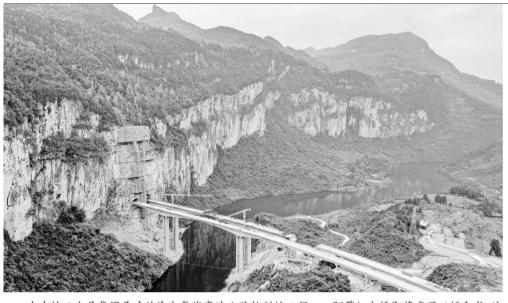
由中铁二十局集团承建的渝湘复线高速公路控制性工程——阿蓬江大桥即将实现双幅合龙, 这 标志着渝湘复线高速彭酉段建设进入冲刺收尾阶段,为全线通车奠定了坚实基础。阿蓬江大桥位于 武陵山区腹地的重庆市酉阳土家族自治县龚滩镇境内,大桥横跨阿蓬江,桥梁全长515米,最大墩高 67米。据介绍,项目最大难点在于桥与崖壁相连,崖壁高度近190米,大桥临崖最大坡度近90度,桥 梁部分深入崖壁形成"隧中桥"。图为11月26日拍摄的阿蓬江大桥施工建设现场。
