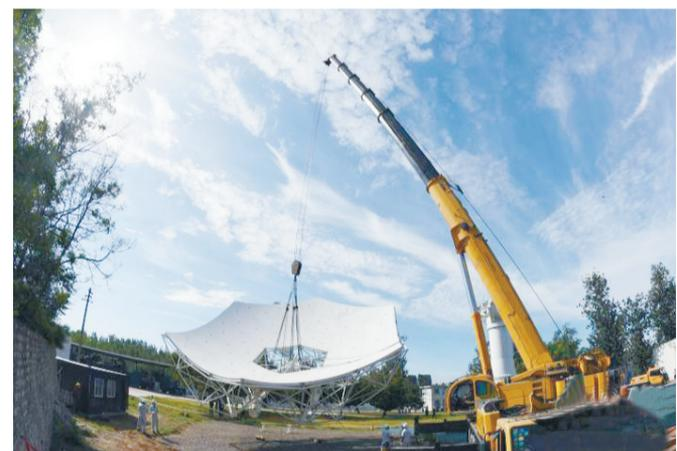
9月20日,中国参与研制的国际大科学工程平方公里阵列射电望远镜项目(以下简称SKA项目)中频天线结构进入建设阶段后的首台天线,在中国电科网络通信研究院测试现场正式吊装。这是SKA进入建设阶段以来建成的首台天线,是继2022年底,科技部联合SKA天文台,成功举办SKA中频天线结构实物贡献协议线上签署仪式后,又一里程碑事件。标志着中国在SKA核心设备研发中发挥引领和主导作用,在国际大科学工程中,为世界成功提供“天线解决方案”,为国际天文领域再做重要贡献。 人民网图片
