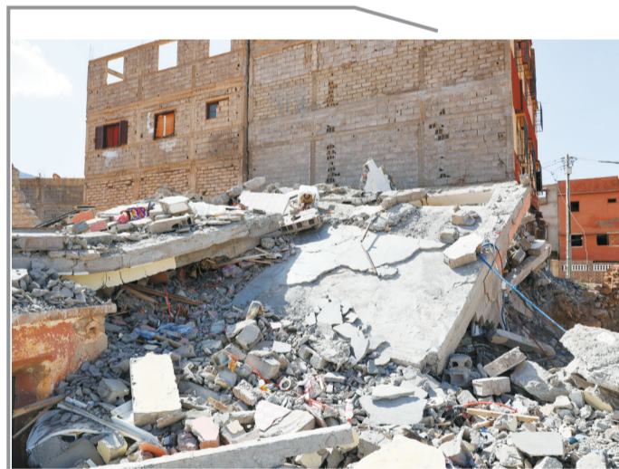
这是9月10日在摩洛哥震中附近的马拉喀什市艾米兹米兹村拍摄的损毁建筑。 新华社照片
