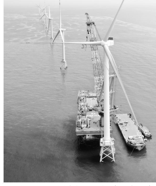
7月19日，16兆瓦超大容量海上风电机组在三峡集团福建海上风电场成功并网发电，标志着我国海上风电大容量机组研发制造及运营能力再上新台阶。这是16兆瓦超大容量海上风电机组安装完成现场（6月28日摄，无人机照片）。
