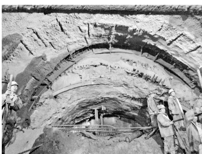
胡麻岭隧道建设现场资料图。
